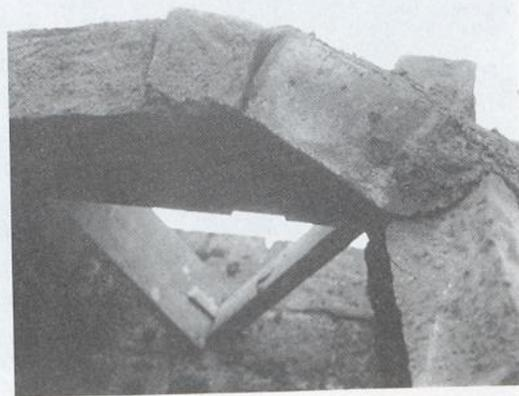
11) En la tercera hilera de ladrillos que pertenecen a la parte curva de la cúpula, deberán dejar un hueco de 15 cm x 15 cm que es el que formará la tronera. Al llegar a la altura indicada, cierren el hueco que forma la tronera colocándole un ladrillo encima, y continúen con la construcción de la cúpula de la manera que se ha indicado.
